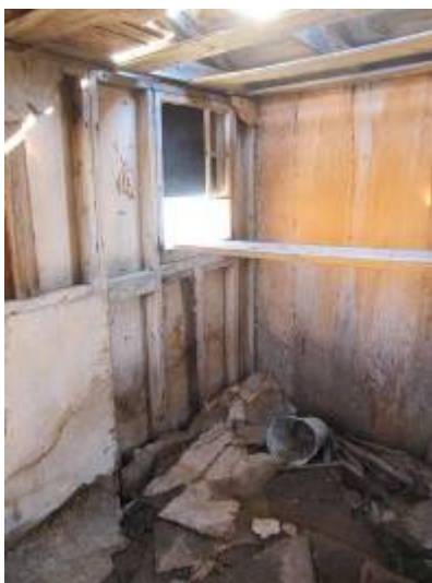
T.v. Gennemvædede træfiberplader. T.h. Huset graves fri for at kunne tørre.
