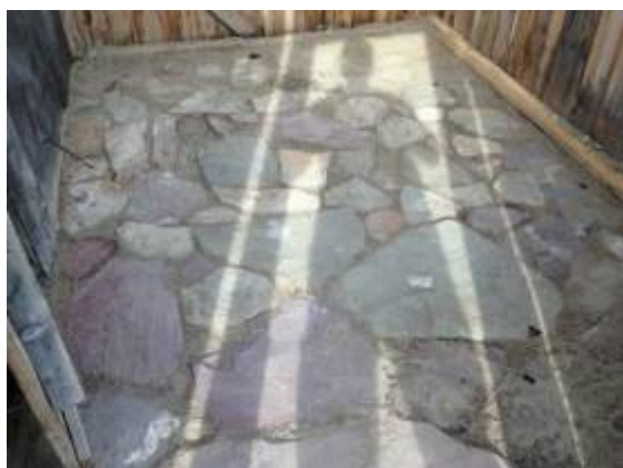
T.v. Gulvet i forrummet blev lavet af flade strandsten. T.h. Nyt navneskilt.
